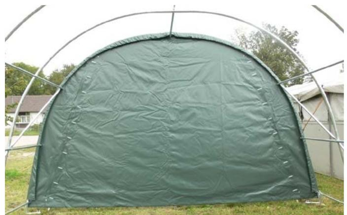
12. Spannen Sie das Spannseil mit aller Kraft gleichmäßig rechts und links in Richtung nach unten und befestigen Sie es an der Stahlschiene am unten befindlichen Eckstab.
