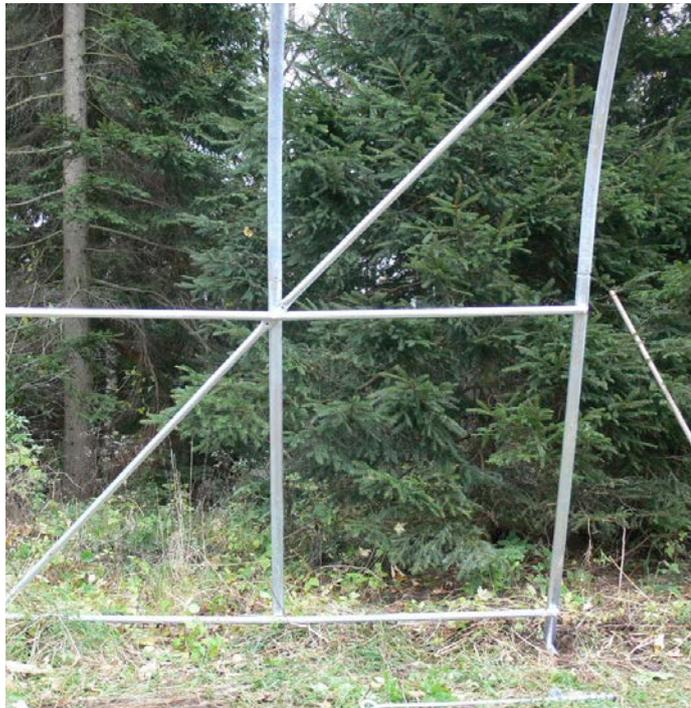
8. Das die Bögen in ihrer Mitte verbindende Rohr wird beim ersten und letzten Bogen unter die Bögen geschoben. Im Gegensatz hierzu wird das Verbindungsrohr auf den Innenbögen auf der oberen Kante der Bogenrohre positioniert.
